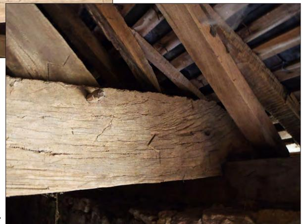
Fig. 96 Détail de marques de charpentier sur l'entraît et l'arbalétrier.
