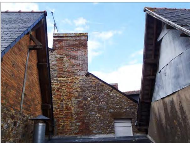
Fig. 90 Vue de la cour créée en démolissant la moitié nord du bâtiment dit de «la boulangerie» (sur la gauche). On observe sur les deux pignons les pannes, la sous-faîtière et les croix de saint-André de la charpent qui se prolongeait à l'origine sur les deux bâtiments. Un pignon en pierre te brique est venu fermer l'ancienne boulangerie tandis qu'un pan de bois enduit ferme le bâtiment 2.
